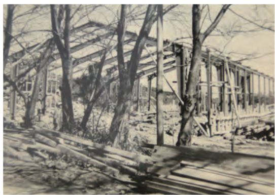
1960～65年 旧聖堂建設中
